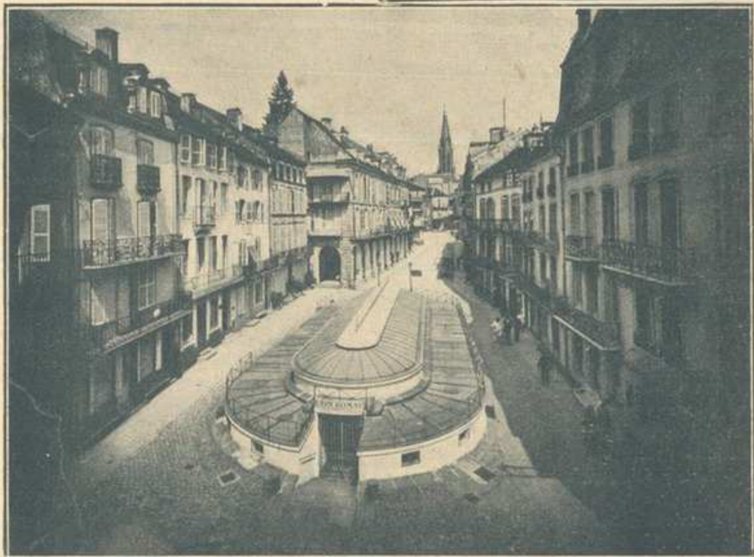
Odkopane termy rzymskie w Plombières działają równie wprawno jak w czasach wielkiego Imperjum. Jedyne poziom ulicy podniósł się o kilka metrów, wskutek czego termy znalazły się w podziemiach
