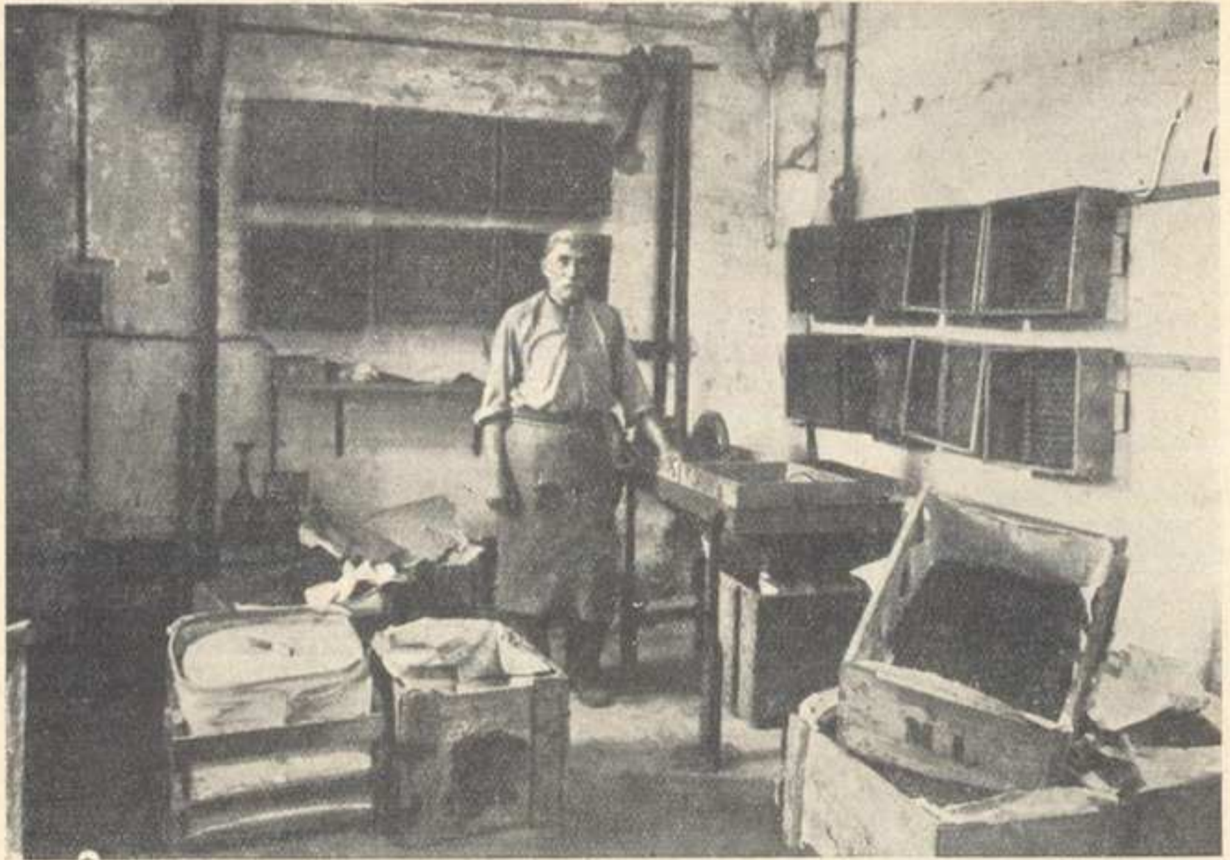
Przesiewanie paciorków za pomocą czworokątnych sit, poruszonych motorem elektrycznym. Przed maszyną stoją skrzynie z paciorkami
